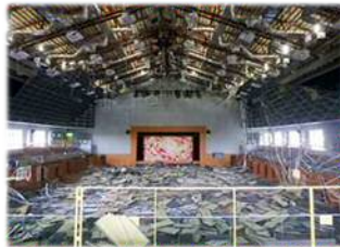
落下した吊り天井 （熊本地震：益城町）
