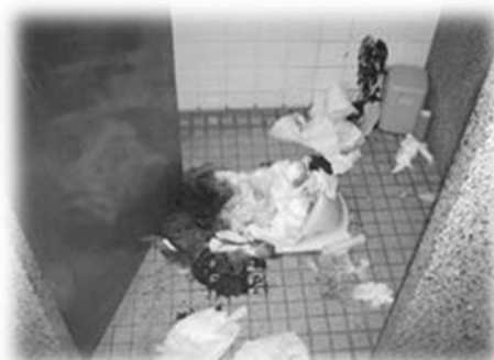
断水により汚れたトイレ
