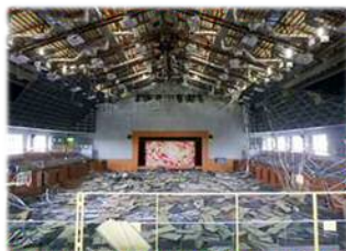
落下した吊り天井 （熊本地震：益城町）
