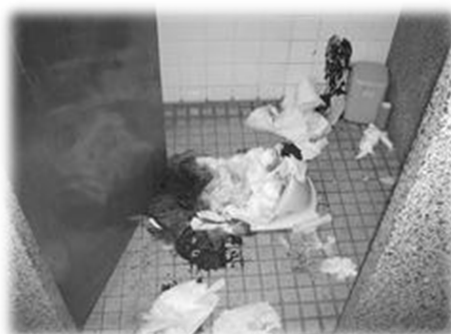
断水により汚れたトイレ
