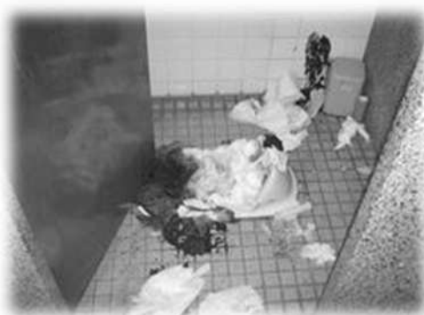
断水により汚れたトイレ
