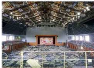
落下した吊り天井 （熊本地震：益城町）
