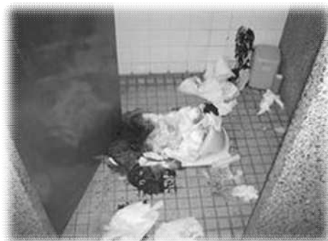
断水により汚れたトイレ
