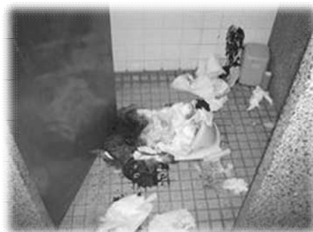
断水により汚れたトイレ
