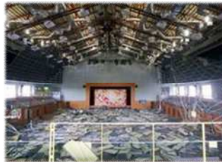
落下した吊り天井 （熊本地震：益城町）
