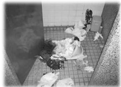
断水により汚れたトイレ
