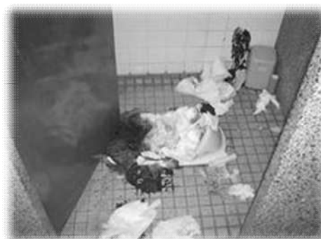
断水により汚れたトイレ
