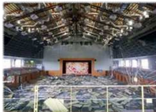
落下した吊り天井 （熊本地震：益城町）
