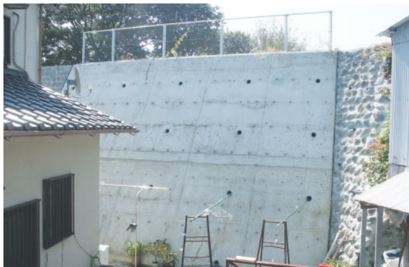
坂下急傾斜地崩壊対策工事
