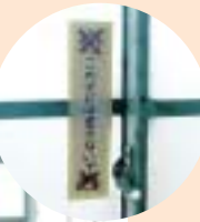
⑥サッシの錆による窓の開閉不能▶
