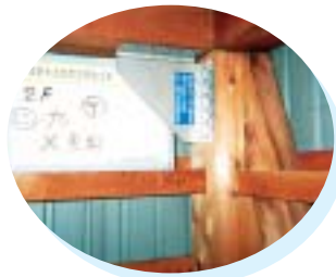
▲仕口ダンバーによる補強
