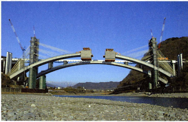
アーチリブの施工状況(平成15年2月頃)
