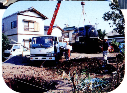
▶合併処理浄化槽の設置工事の様子です。
