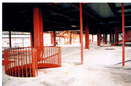
内部の工事も進んでいきます。
