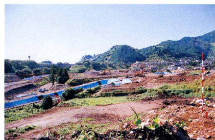
平成10年7月から造成工事が始まりました。
