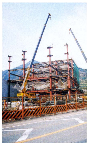
鉄骨が立ち上がり始めました。
