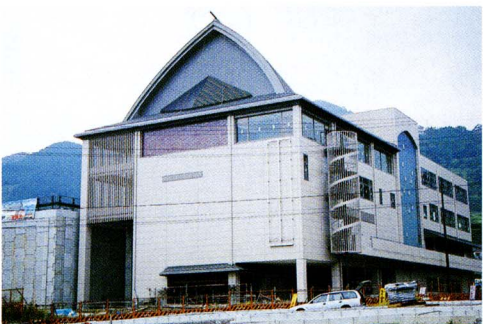
順調に工事が進んでいます。
