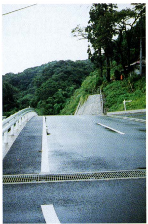
農免農道工事 (四十九地区)
