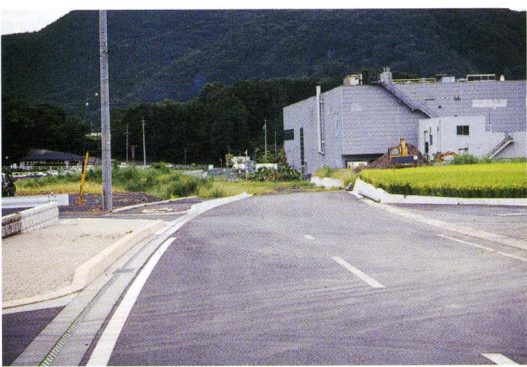
県道とサン・クレア富士川を結ぶ特定原方小車線改良工事です。
