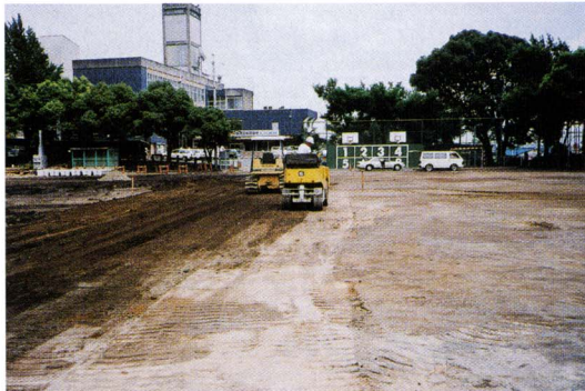
第一小学校のグラウンドは改修工事により、水はけがよくなりました。
