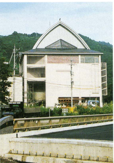
来年三月オープンに向けて、ウォーターワールド整備事業の工事が進んでいます。
