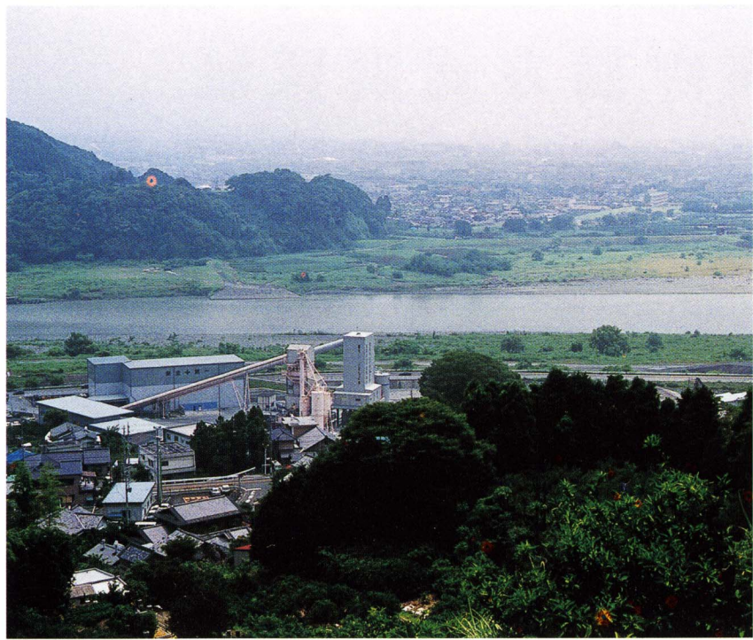
木島地先から対岸の富士市側を望む
