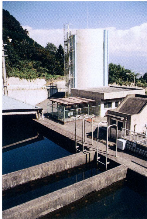
吉津の配水池及び浄水場
