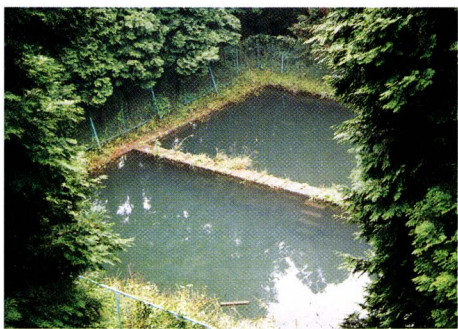
昔、ここから赤痢が発生しました。(旧一小専用水道)
