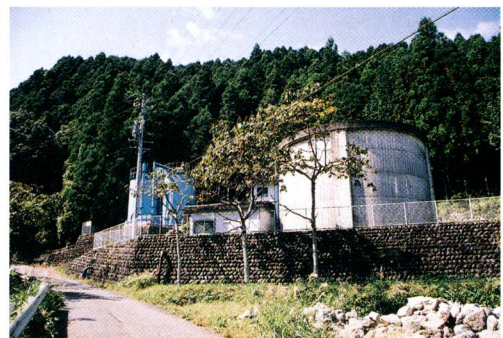
北松野配水池です
