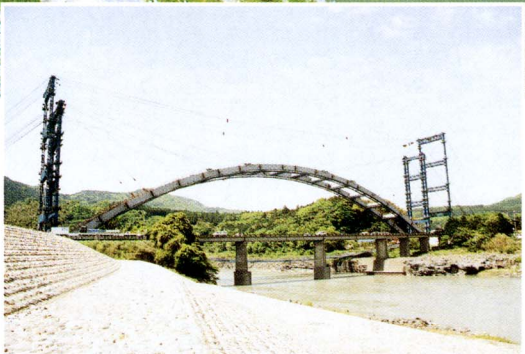
アーチ部分ができました
