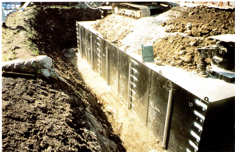
来るべく、東海地震に備え、耐震防火貯水槽（40t）を3基築造する予算も計上しました。(消防施設工事関連59,480千円)
