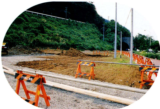
新築工事現地
