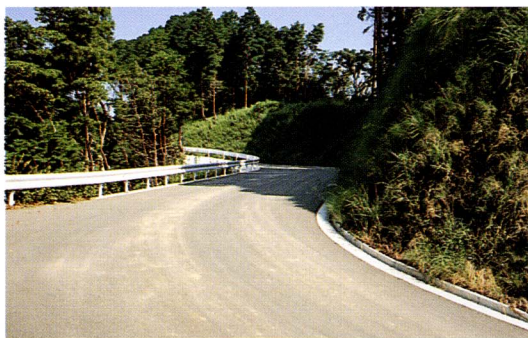
大平農道改良工事
