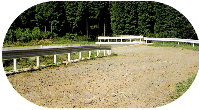
農免道中之郷地区工事
