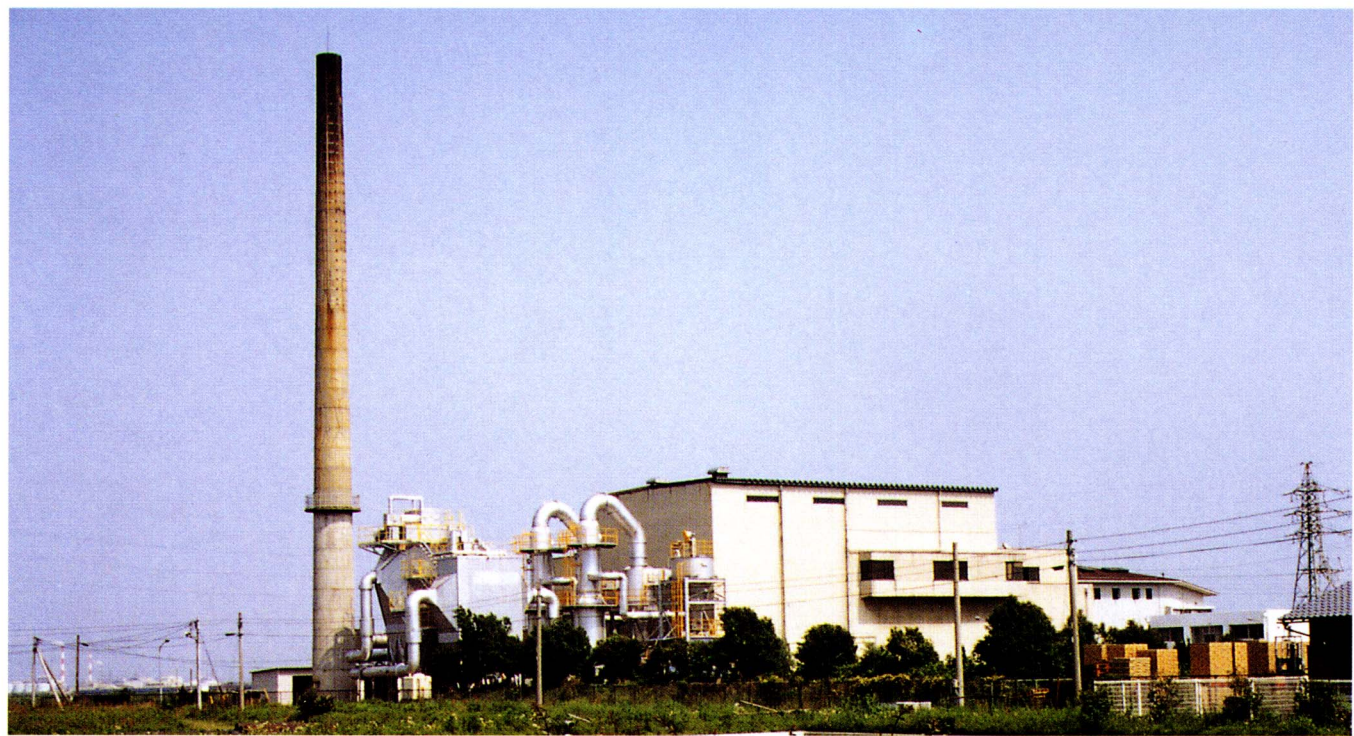
高濃度ダイオキシンが検出された富士川クリーンセンター
