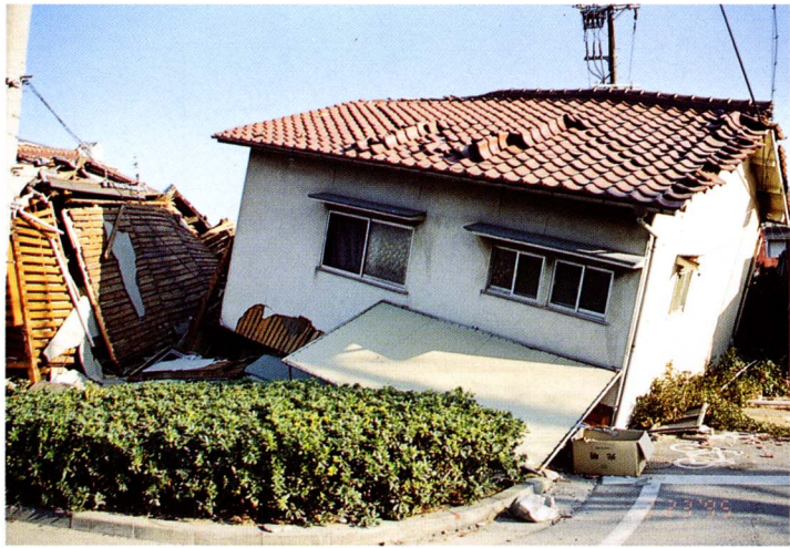
大地震により、倒壊した家屋
