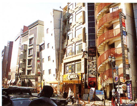
窓ガラスが割れていない？
