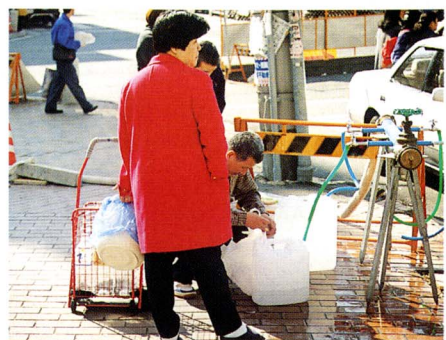
消火栓が仮給水所に…
