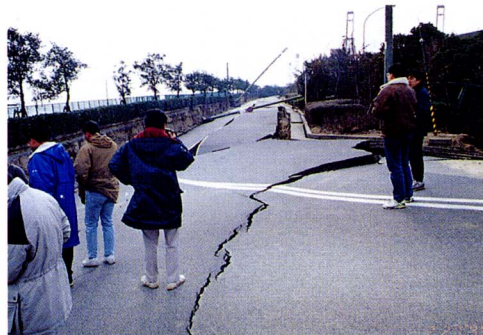
陥没してしまった道路...
