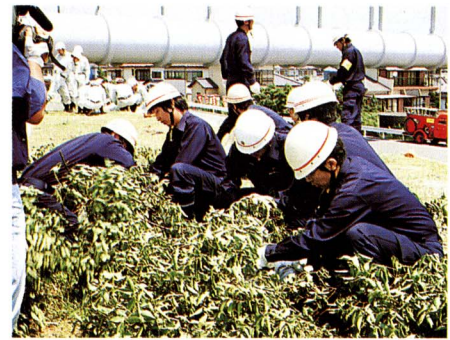
土のうを結んで木流しだ!
