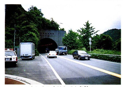
トンネル内はとても危険!
