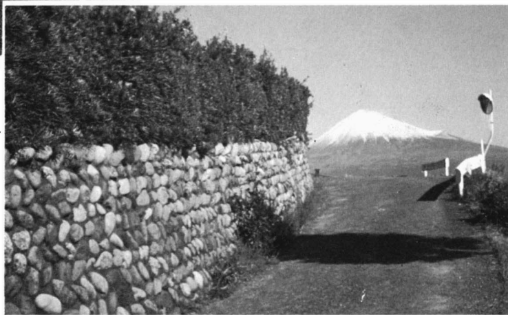
昭和45年当時の吉津から室野までの町道。車一台が通れば、いっばいの道路でした。
