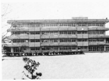
耐震補強工される二中校舎
