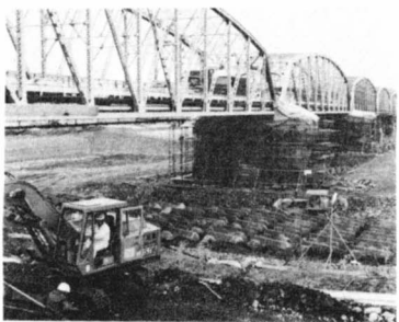
拡幅工事が進む富士川橋
