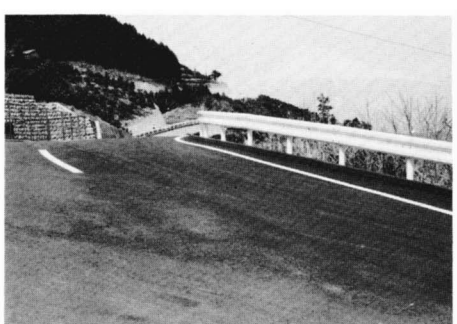
まもなく完成する農免農道
