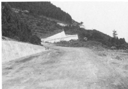
建設が進む 農免岩渕道路
