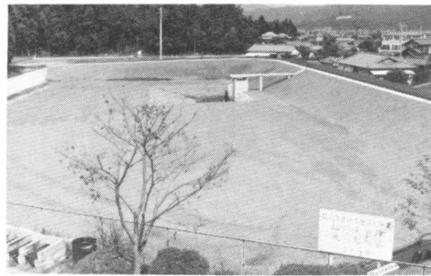
補修が進む 温水ため池
