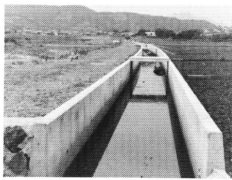
かんがい排水路整備が進む北松野沖田
