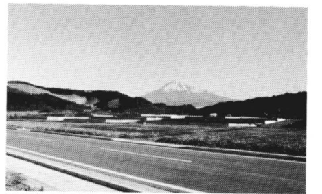
造成工事進行中
