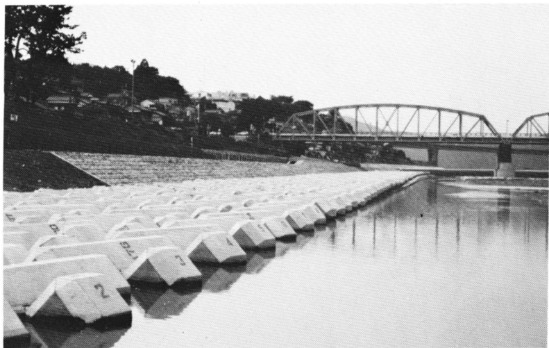
完成した坂下地先の護岸工事
