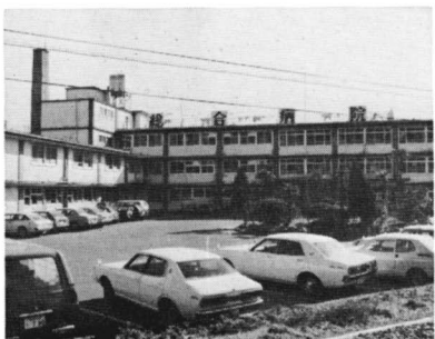
老朽化が進む蒲原病院
