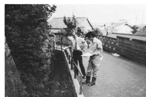
新町の危険な排水溝
