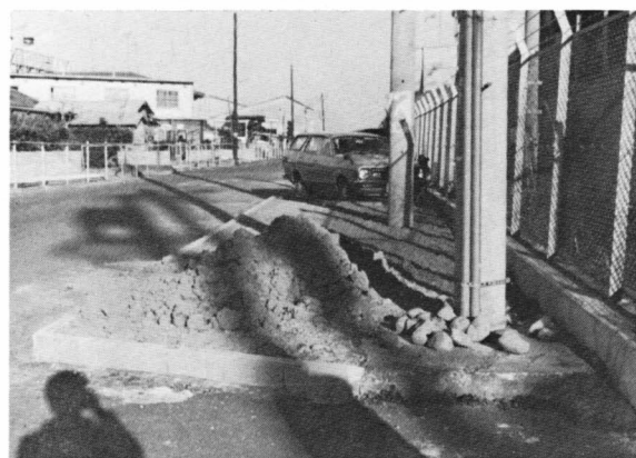
日の出町区の国鉄新幹線側道わきの 整地中のところ(現在は植樹されている)
