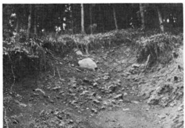
災害復旧工事農地(小山)
