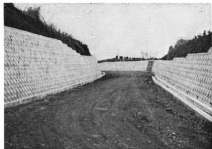
農免道路の完成している箇所(新井地先)
