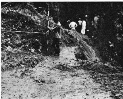
ガケくずれ、道路決壊によって不通になった平清水漆野線
