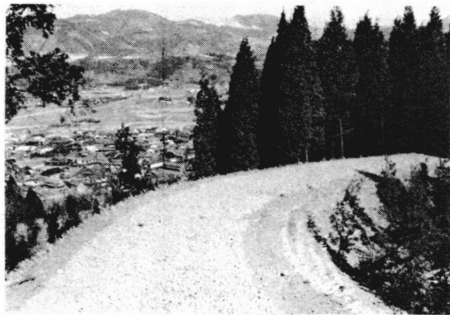
新設された林道粒良野八棟線
