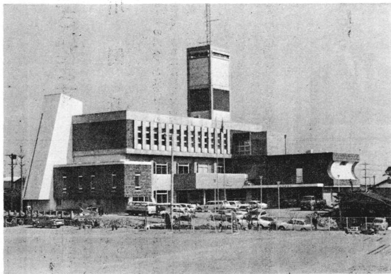
完成した新庁舎、および富士川消防所 昨年12月20日から執務をはじめています。
