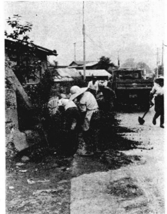
写真 水路の清掃
