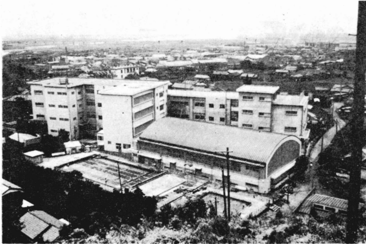
写真 四期工事を終え、総合校舎を形成した一小。体育館（半円屋根）の左端、四階建の建物がこんど完成した特別教室（2・3・4階）と給食センター（1階）
